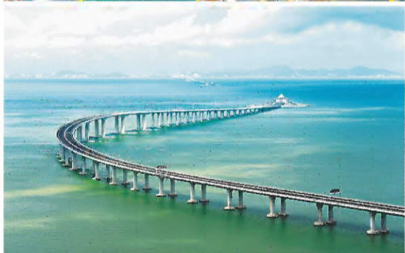
9月に開通した「広深港高速鉄道」。広州、深圳、香港を結ぶ 世界最長、55*。の海上橋、「港珠澳大橋」
